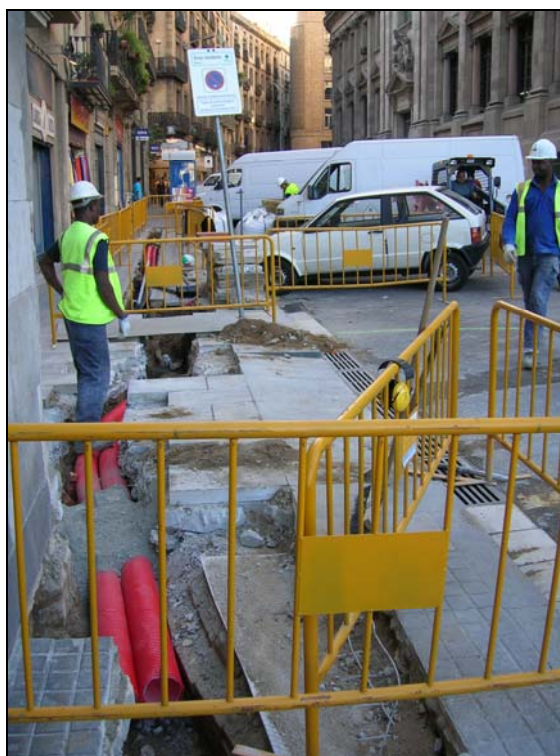
Foto 6: Col·locació tubulars per on anirà la nova línia elèctrica
