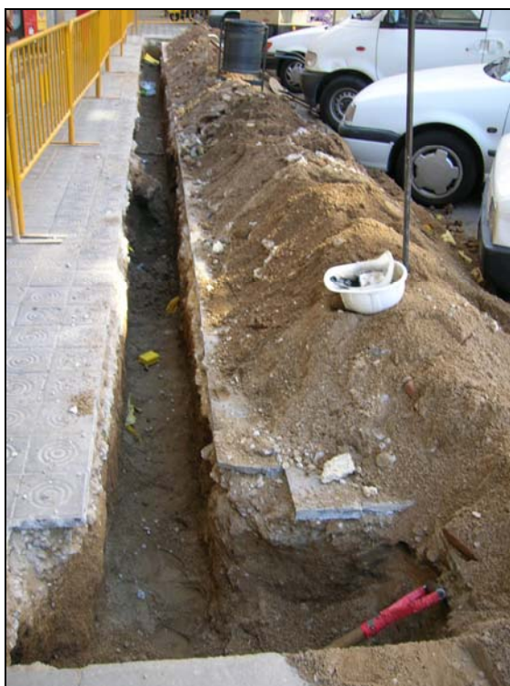
Foto 4: Obertura de la rasa 100
