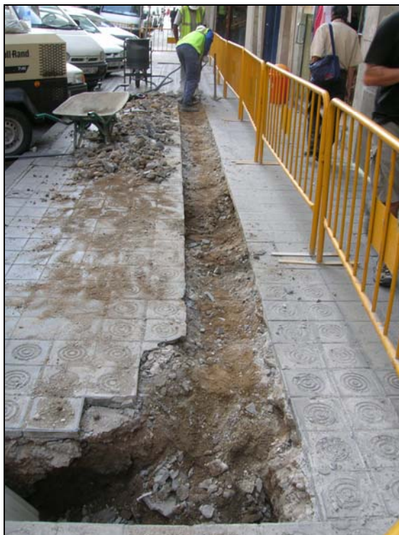
Foto 3: Aixecament dels panots de la vorera
